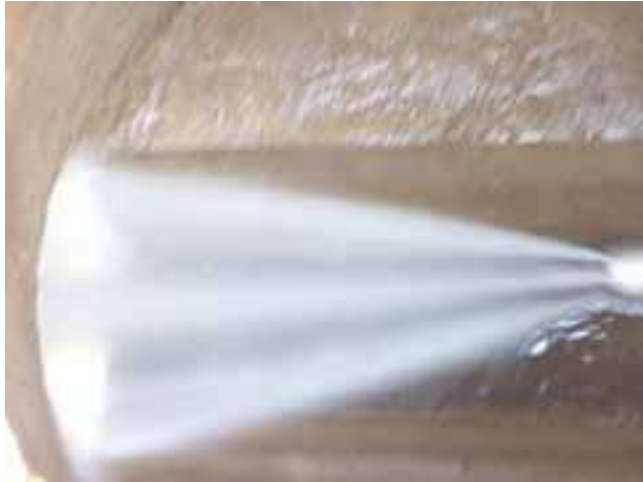
Fig. 29: Limpieza del tramo
