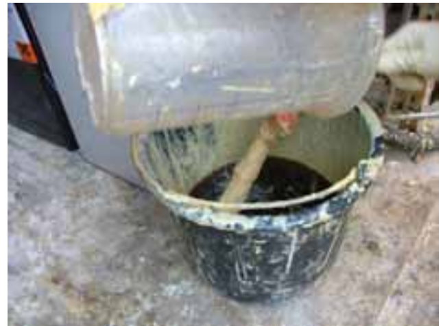
Fig. 12: Añadir el componente B a la mezcla previa A+C en un recipiente de mayor capacidad
