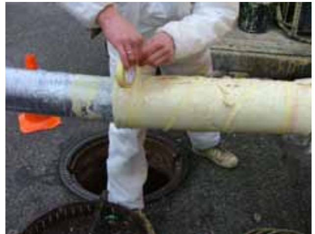
Fig. 22: Fijar el manguito sobre el packer
