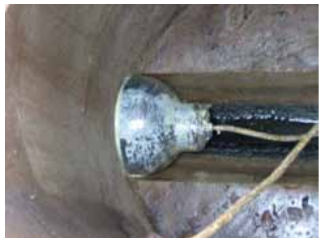
Fig. 24: Packer inflado en el tramo dañado
