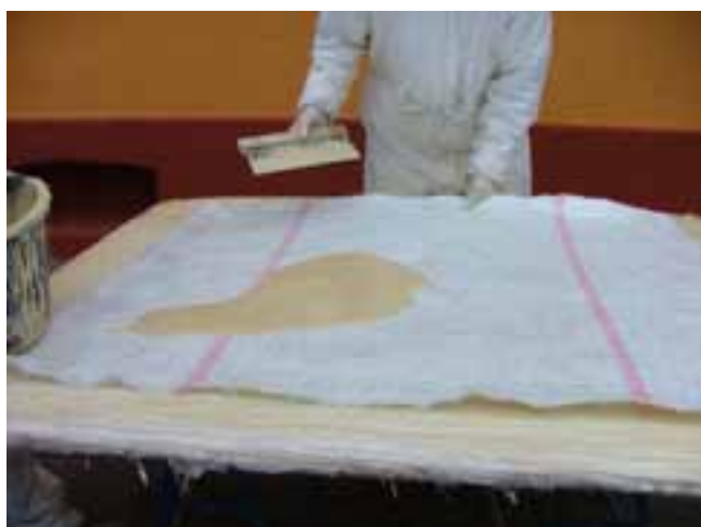
Fig.15: Aplicar la resina sobre la malla de fibra de vidrio
