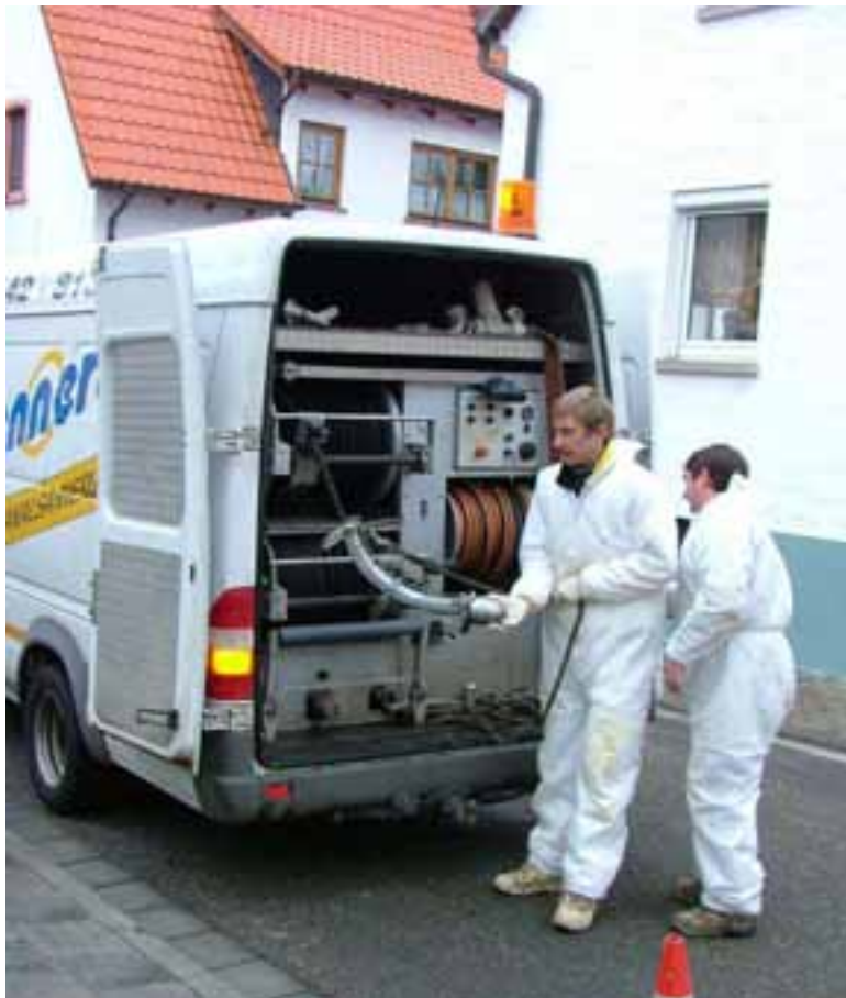
Fig. 2: Preparación del tramo mediante limpieza a alta presión
