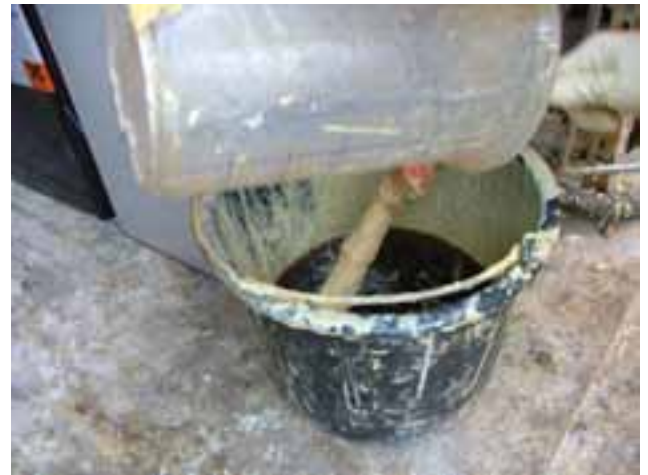
Fig. 12: Añadir el componente B a la mezcla previa A+C en un recipiente de mayor capacidad
