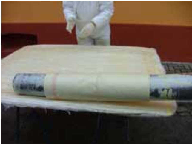
Fig. 21: El manguito corto enrollado
