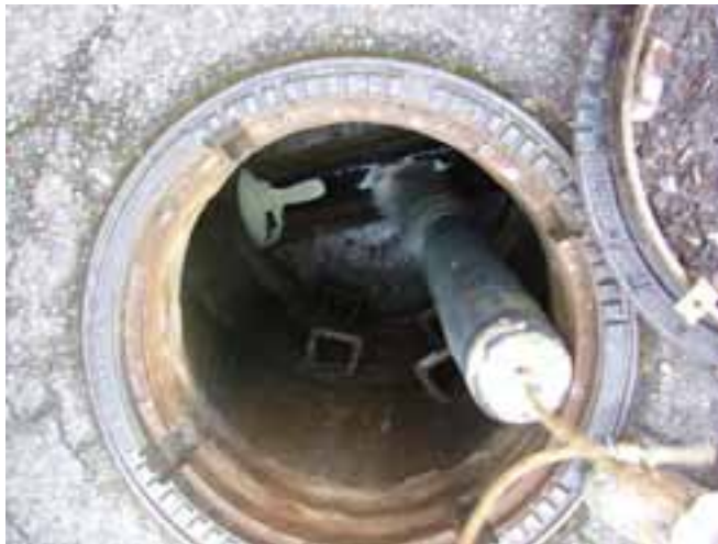
Fig. 25: El packer es retirado finalizada la reparación
