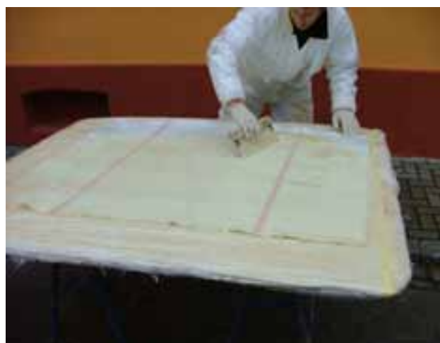
Fig. 16: Distribuir la resina sobre la parte anterior de la malla de fibra de vidrio
