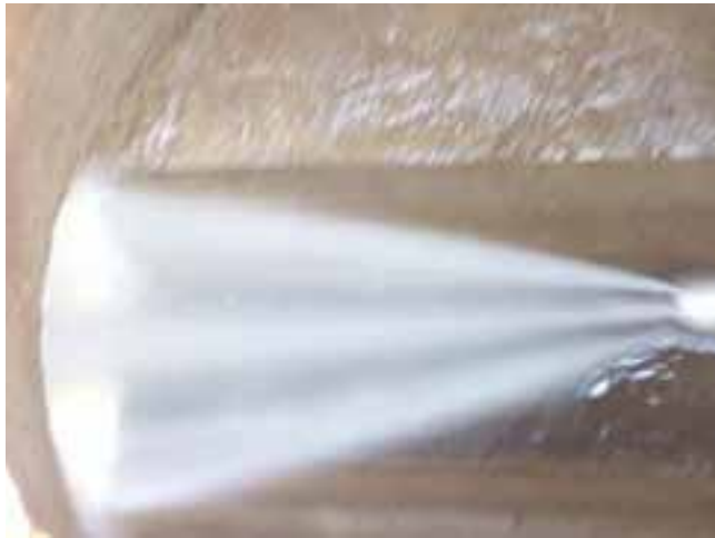
Fig. 29: Limpieza del tramo
