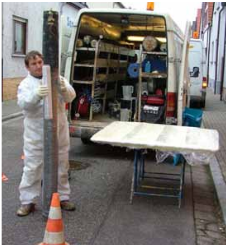
Fig. 5: Envolviendo el packer con una lámina
