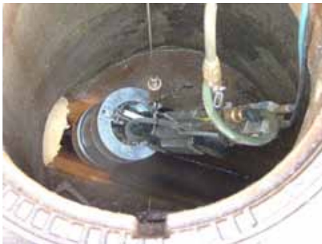
Fig. 31: Introducción del aparato para la prueba en el pozo
