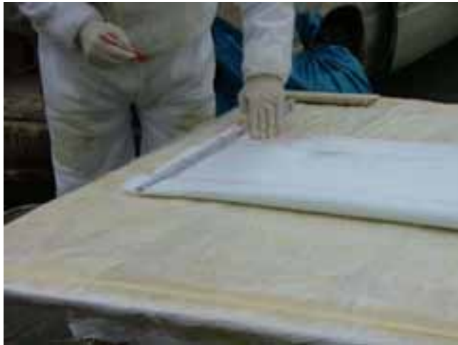
Fig. 3: Medición de la longitud del manguito corto
