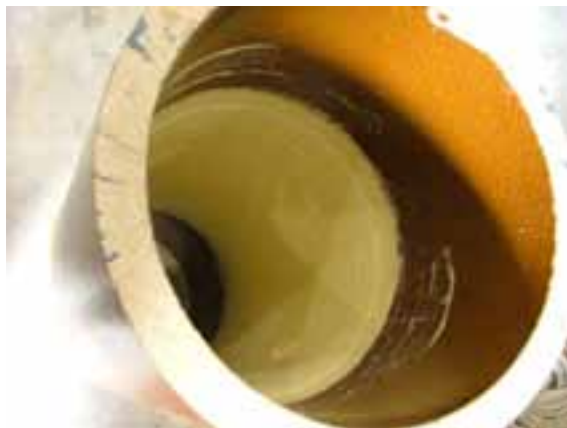
Fig.16: Manguito montado en la tubería de cerámica
